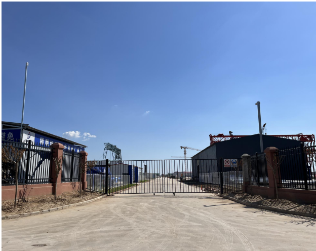
图 3-5 电厂施工现场
